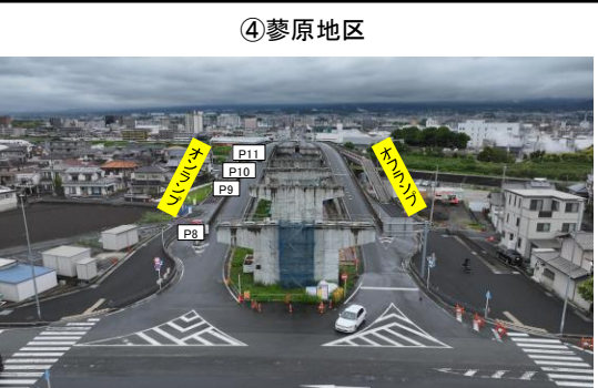
P8橋脚から北側を望む
