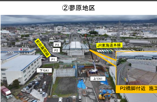
A1橋台から北側を望む
