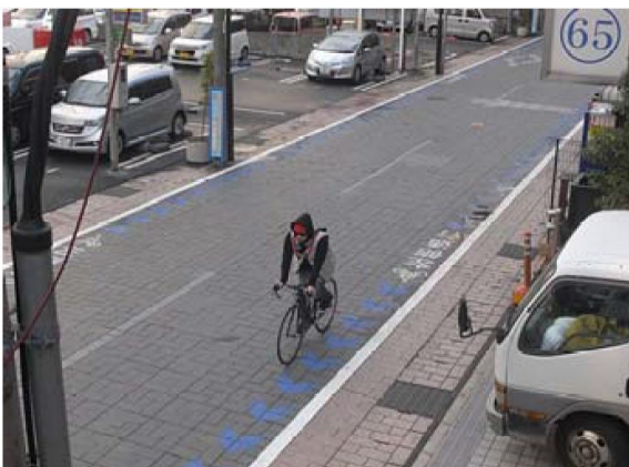
写真 3-5 車道左端部の路肩内に矢羽根型の 路面表示を設置した事例 (歩道のない道路)
