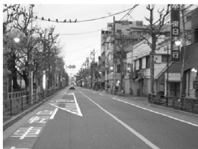
写真 5-3 バス停留所部を示す路面表示を設置した
