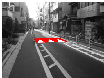
写真 3-9 車道部分にハンプを設置し ハンプの両側にゴム製ポールを設置した事例
