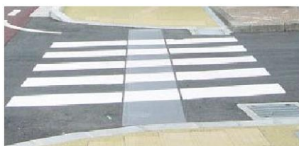
写真 5-2 横断歩道におけるエスコートゾーンの設置例
