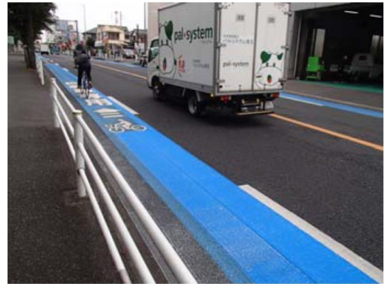
写真 3-2 自転車専用通行帯の事例 (幅の全部をカラー化)
