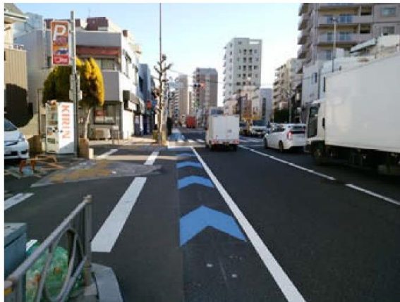
写真 3-3 車道左端部の路肩内に矢羽根型の 路面表示を設置した事例
