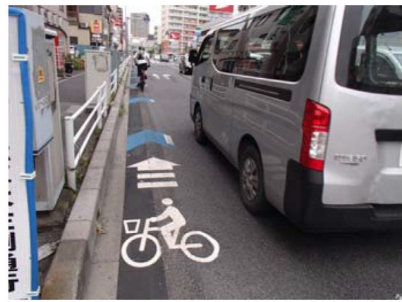
写真 3-4 車道左端部の車線内に矢羽根型の 路面表示を設置した事例 (歩道のある道路)
