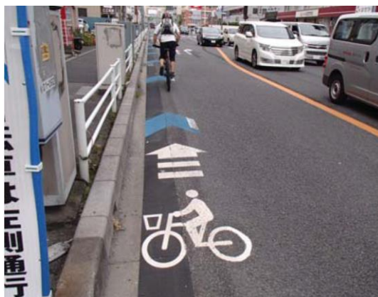
写真 3-6 ピクトグラムを設置した事例
