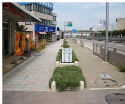
植樹帯に設置した事例 (国道 19 号春日井市)
