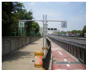
柵、車止めによる分離構造 (国道23号 名古屋市南区名南橋)
