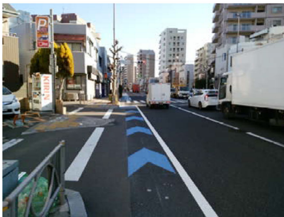
写真 3-3 車道左端部の路肩内に矢羽根型の路面表示を設置した事例
