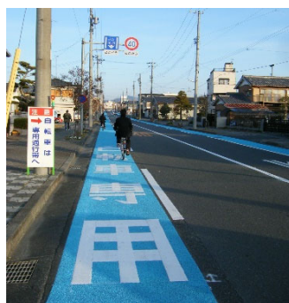
写真 4-2 自転車専用通行帯として整備した事例（静岡県菊川市）
