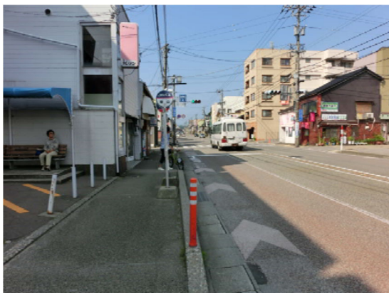
写真 3-7 バス専用通行帯を活用し路面表示を設置した事例
