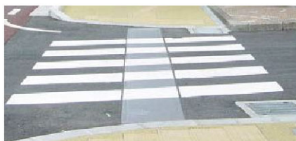
写真 5-2 横断歩道におけるエスコートゾーンの設置例
