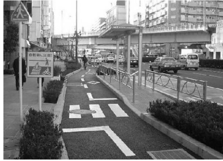
写真 5-1 交通島を設置し、道路標識及び道路標示を設置した事例
