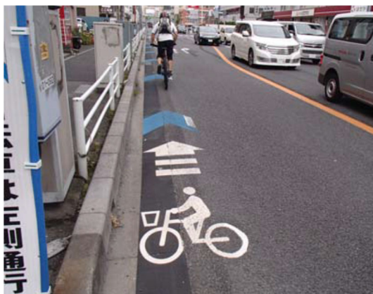
写真 3-6 ピクトグラムを設置した事例
