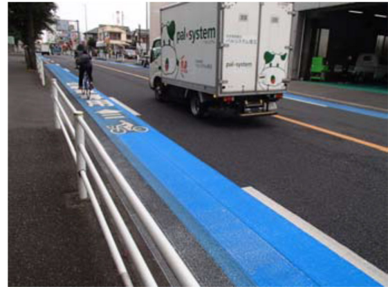
写真 3-2 自転車専用通行帯として整備されている事例 (幅の全部をカラー化)
