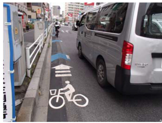
写真 3-4 車道左端部の車線内に矢羽根型の路面表示を設置した事例 (歩道のある道路)
