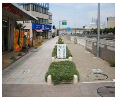
植樹帯に設置した事例 (国道 19 号春日井市)
