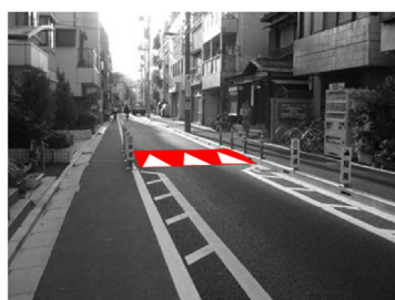
写真 3-9 車道部分にハンプを設置し ハンプの両側にゴム製ポールを設置した事例
