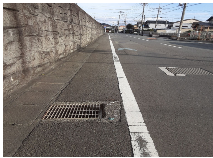
①未舗装、ひび割れ・段差・溝など 細いタイヤ危ない
