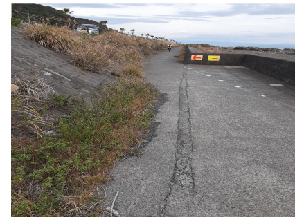
①未舗装、ひび割れ、段差、溝など
