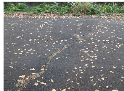
①未舗装、ひび割れ、段差、溝など
