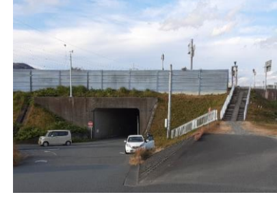
⑬ 階段へ誘導する案内が分かりづらい
