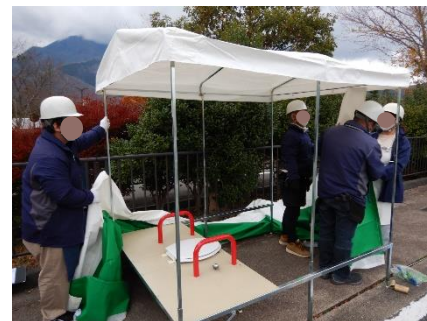
災害用トイレの設置
