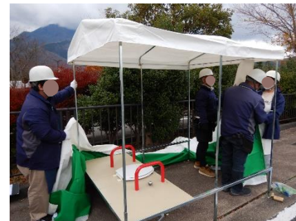
災害用トイレの設置
