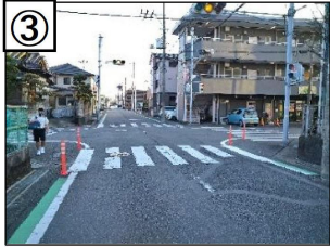
歩行空間整備 (カラー舗装)
