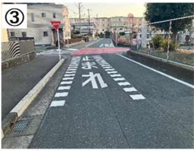
交差点カラー舗装
