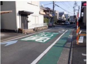
カラー舗装、路面表示
