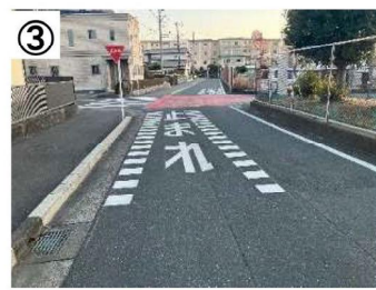
交差点カラー舗装
