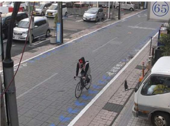
写真 3-5 車道左端部の路肩内に矢羽根型の路面表示を設置した事例
