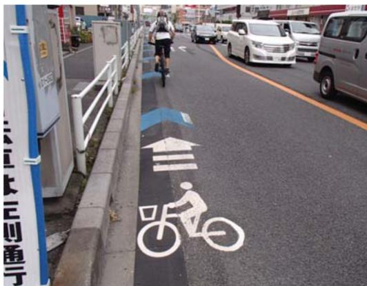
写真 3-6 ピクトグラムを設置した事例
