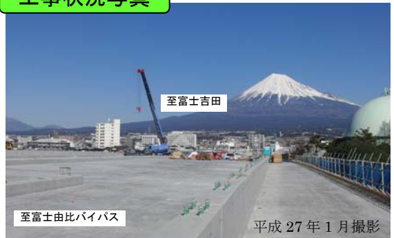
潤井川橋の床版のコンクリートを打設しました。
