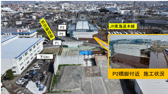
A1橋台から北側を望む
