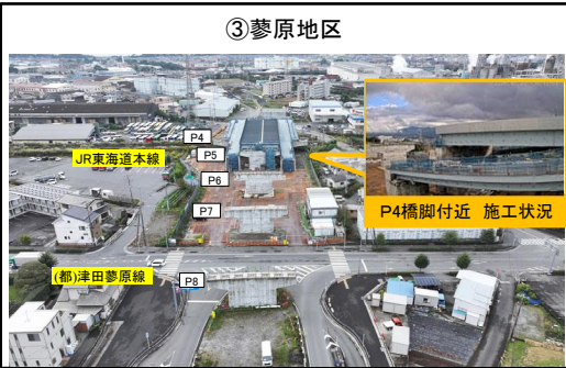
P8橋脚より南側を望む
