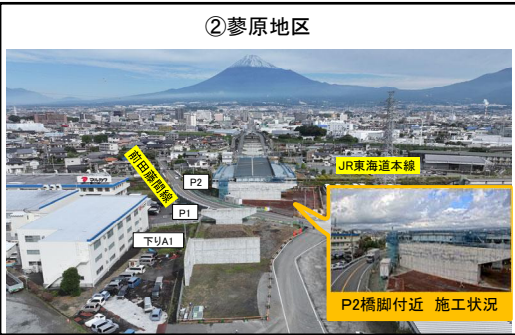
A1橋台から北側を望む
