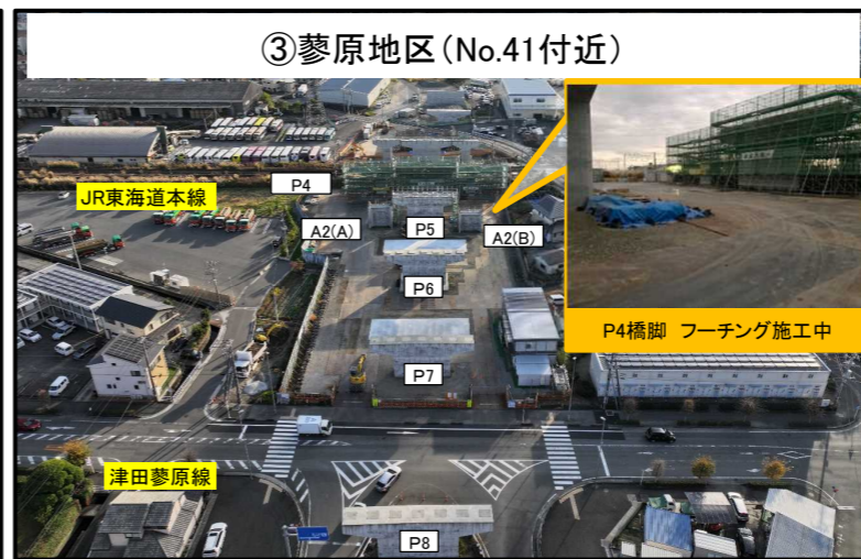
③蓼原地区(No.41付近) P4橋脚 令和5年4月着工
