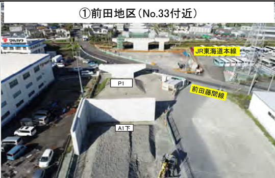
①前田地区 (No.33付近) A1橋脚 下り背面L型擁壁 施工完了
