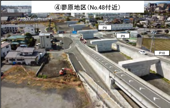
④蓼原地区 (No.48付近) P8・P9・P10橋脚 令和4年2月 施工完了
