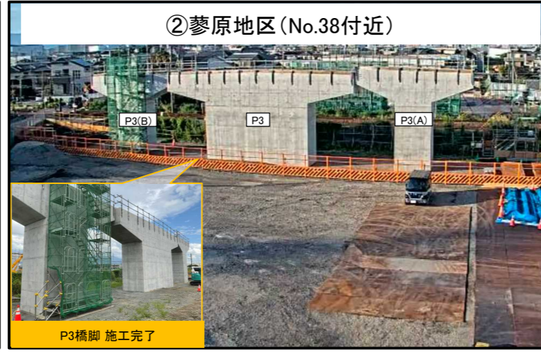
②蓼原地区(No.38付近) P3橋脚 令和5年8月 施工完了
