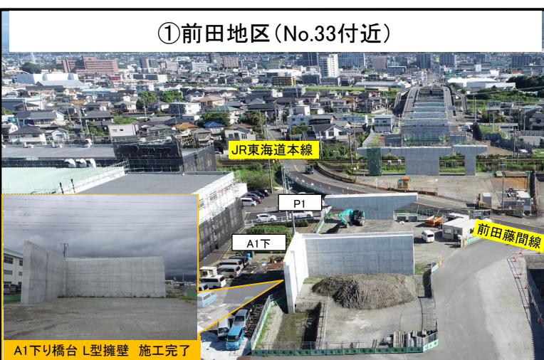
①前田地区 (No.33付近) A1橋脚 下り背面L型擁壁 施工完了
