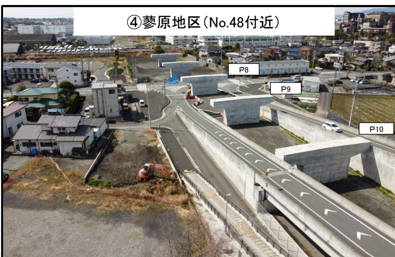
④蓼原地区 (No.48付近) P9・P10・P11橋脚 令和4年2月 施工完了
