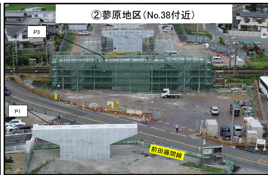
②蓼原地区 (No.38付近) P3橋脚 令和4年9月着工 施工中
