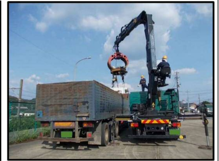
減載措置命令による作業状況
