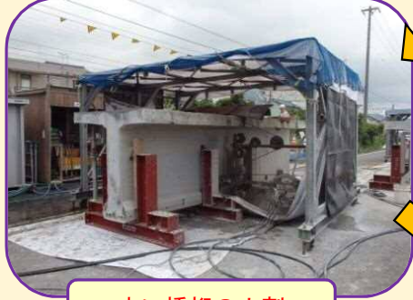
古い橋桁の小割
