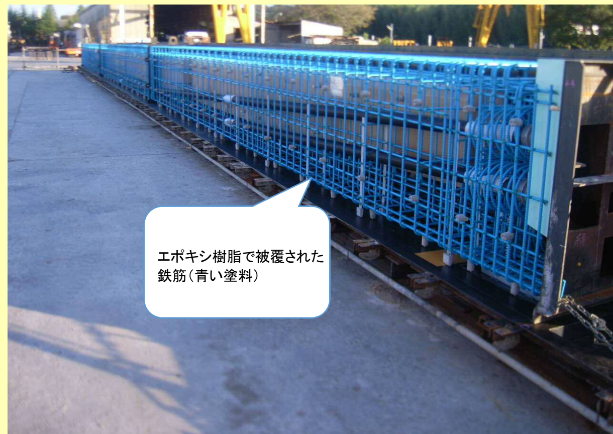
新しい橋桁の製作状況(工場製作)
