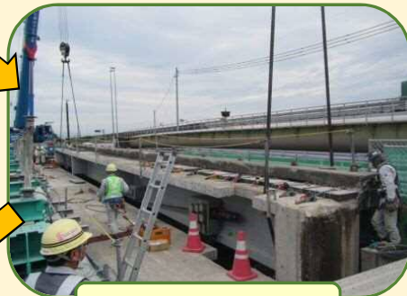
古い橋桁の切りだし
