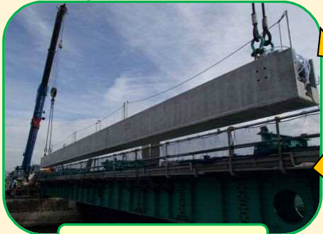
新しい橋の架設
