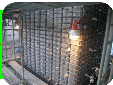
橋脚の周りに鉄筋を組む
