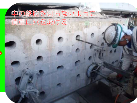
アンカーボルトを入れる穴をあける
