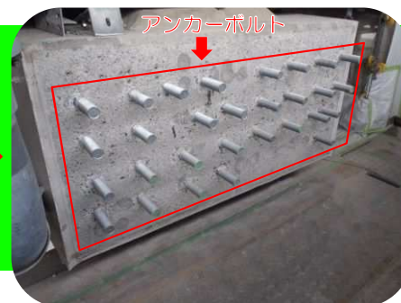
アンカーボルトをセットし樹脂で固める
