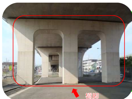
橋脚巻立て施工前
