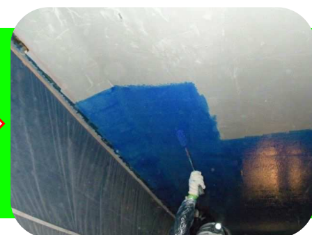
せんいシートを貼るための樹脂を塗る
