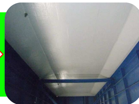
保護用の塗料を塗り重ねて完了
