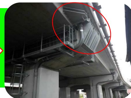
装置をアンカーボルトに差込み固定して完了
