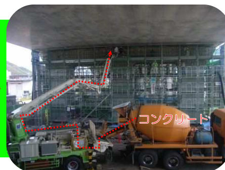
コンクリートを打設
