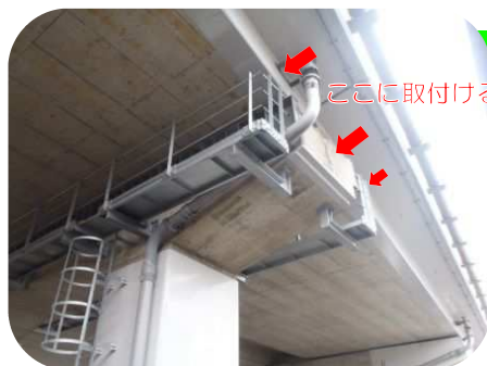
変位制限装置取付前
