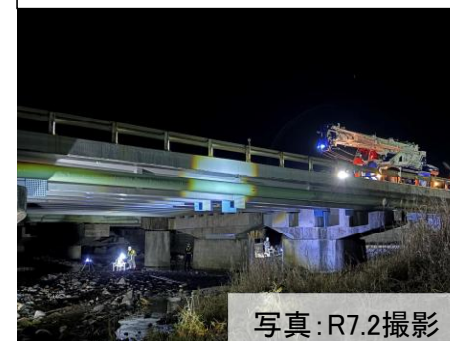
【載荷試験】実施状況
