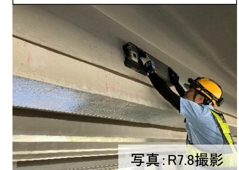
【PC鋼材非破壊検査】実施状況
