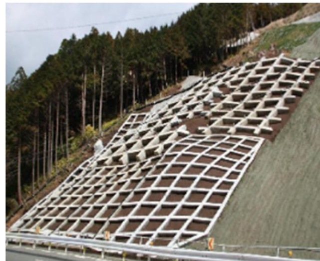
平成26年台風18号による被災箇所の復旧 (平成28年3月完了)
