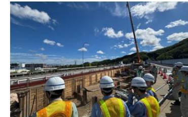
施工技術研修
