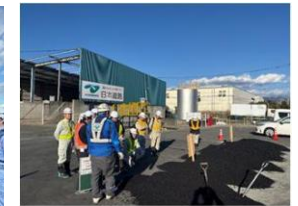
アスファルト工場試験練り
