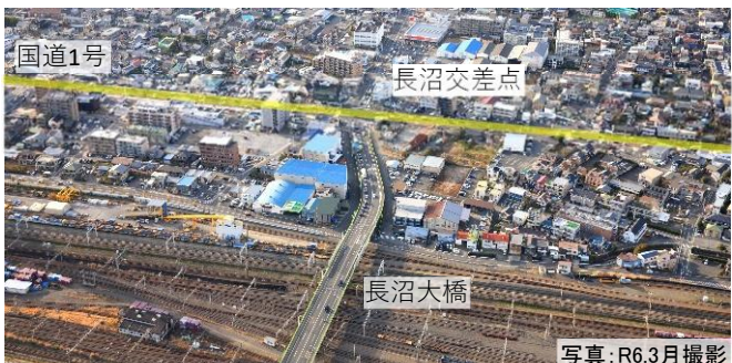
道路調査 (静岡南北道路長沼立体)
