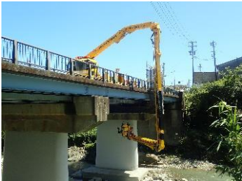
橋梁点検車による点検
