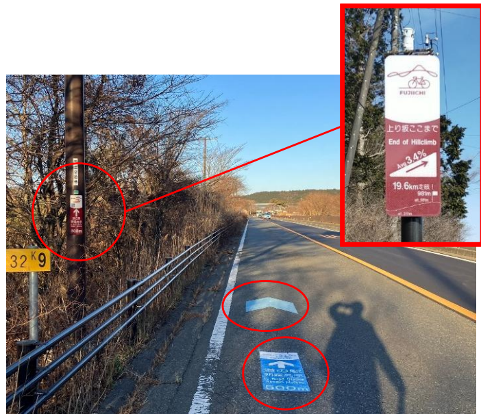
案内標識・路面標示・矢羽根を施工
