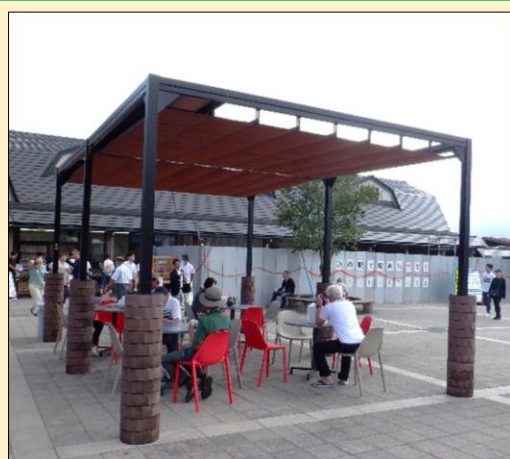
一般国道139号道の駅「朝霧高原」の様子 (ほこみち指定箇所)
