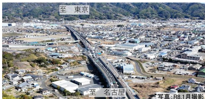
改築 (国道1号藤枝バイパス4車線化事業)
