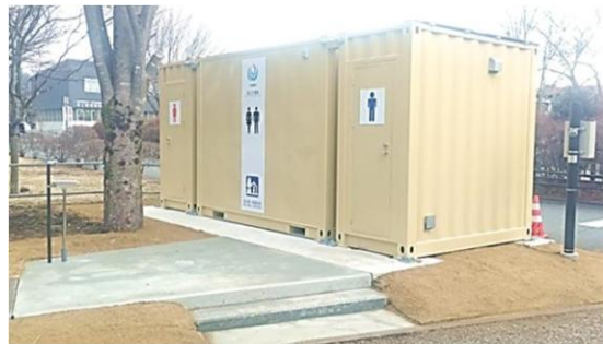
(上下水道に接続せず水洗利用が可能)
