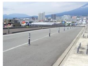
駐停車禁止車止め（ポストコーン）の設置 ※国交省により実施
