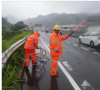
【緊急作業 落下物回収】
