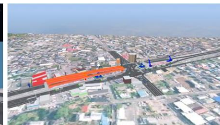
施工箇所全体の様子
