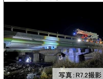
【載荷試験】実施状況
