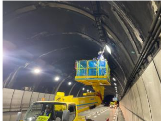
リフト車による打音検査
