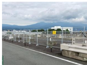
中央分離帯への進入防止のためのフェンスを設置 ※国交省より実施
