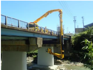
橋梁点検車による点検
