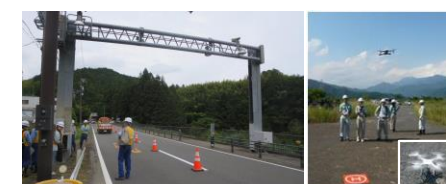
遮断機操作訓練
