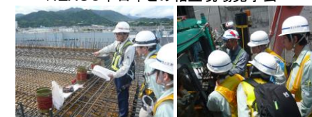
施工技術研修
