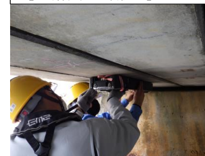
【PC鋼材非破壊検査】イメージ
