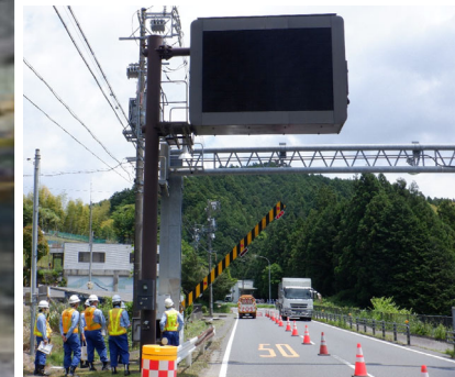
通行止め訓練
