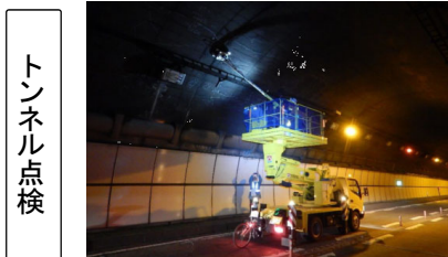
覆工背面空洞電磁波レーダー探査
