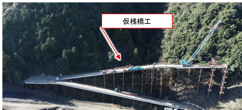
【施工状況(国道1号赤目ヶ谷)】 令和5年2月撮影
