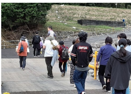
工事用道路築造により歩行者通路を確保
