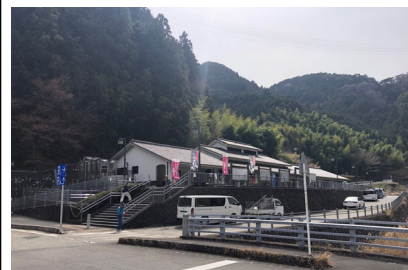
国道1号宇津ノ谷峠(静岡側)
