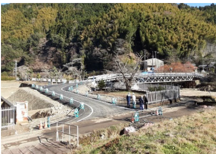
応急組立橋架設により交通を完全に確保
