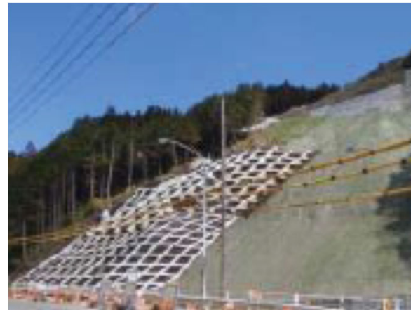
平成26年台風18号による被災箇所の復旧 (平成28年3月完了)
