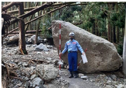
被災状況調査①
