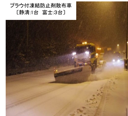
【除雪車による除雪状況】
