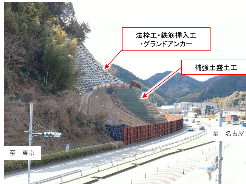
【施工状況(国道1号赤目ヶ谷)】
