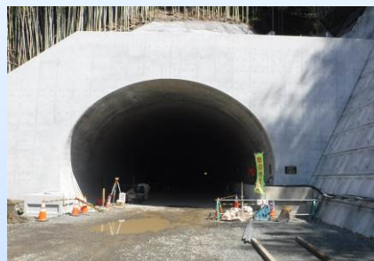
西坑口付近の状況(平成 29 年 3 月)
