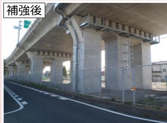
補強前 下部工補強
