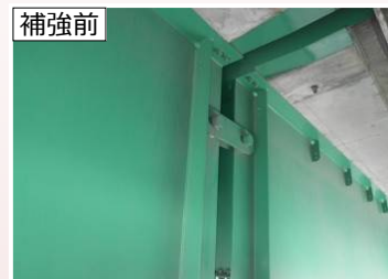
補強前 落橋防止装置
