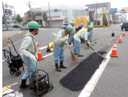
【小規模な路面補修】
