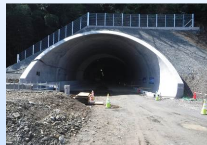
東坑口付近の状況(平成 29 年 3 月)
