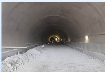
トンネル内の状況(平成 29 年 3 月)
