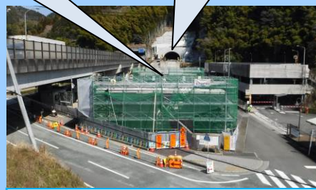
③ 西坑口全景 (丸子 IC 側)
