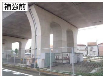
補強前 下部工補強
