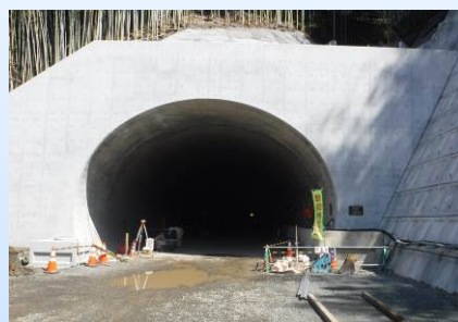
西坑口付近の状況(平成 29 年 3 月)
