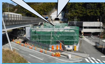
③ 西坑口全景 (丸子 IC 側)
