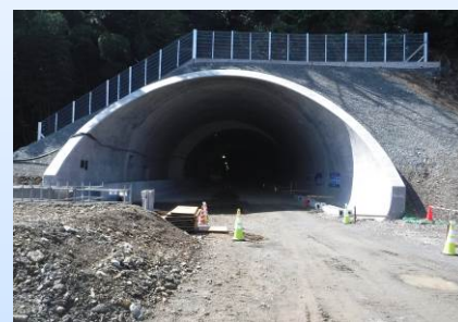
東坑口付近の状況(平成 29 年 3 月)
