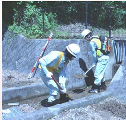
排水溝の土砂の撤去状況
