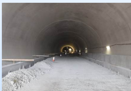
トンネル内の状況(平成 29 年 3 月)
