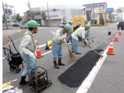
【小規模な路面補修】
