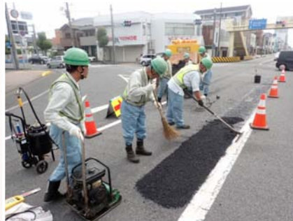
【小規模な路面補修】
