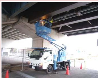
【定期点検により橋梁をきめ細やかに管理】
