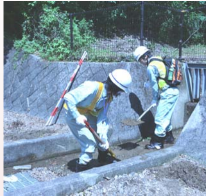
排水溝の土砂の撤去状況
