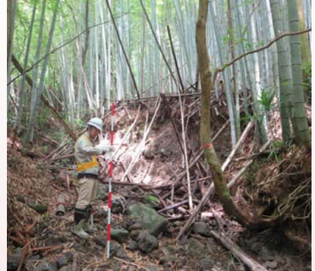
土石流箇所の状況確認
