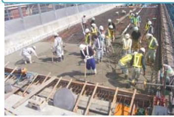
床版 コンクリート打設状況
