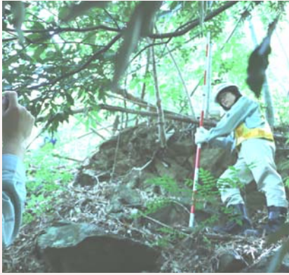
落石箇所の状況確認
