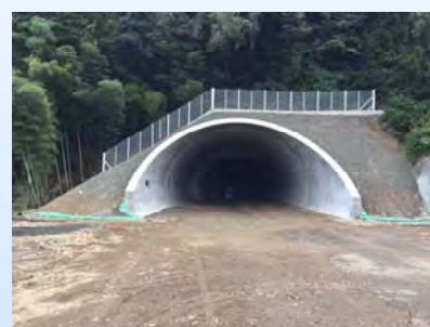
東坑口付近の状況(平成 28 年 1 0 月)
