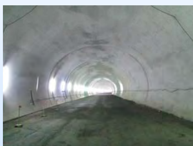
トンネル内の状況(平成 28 年 1 0 月)
