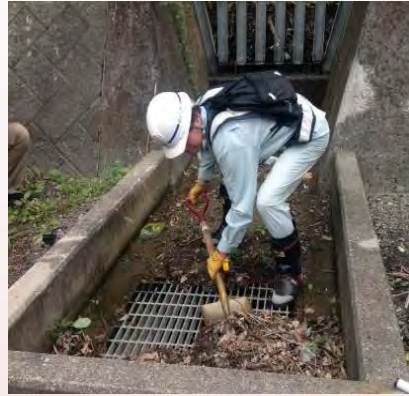
排水溝の土砂の撤去状況
