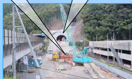
西坑口全景 (丸子 IC 側)
