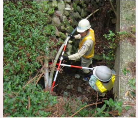
道路横断水路の状況確認
