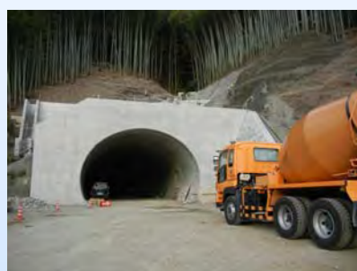
西坑口付近の状況(平成 28 年 1 0 月)
