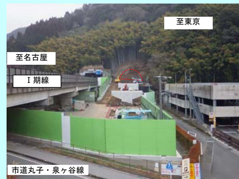
①丸子藁科トンネルⅡ期線（西側）
