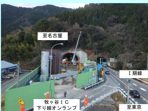
②丸子藁科トンネルⅡ期線（東側）
