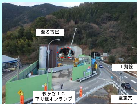
トンネルを掘削しています。
