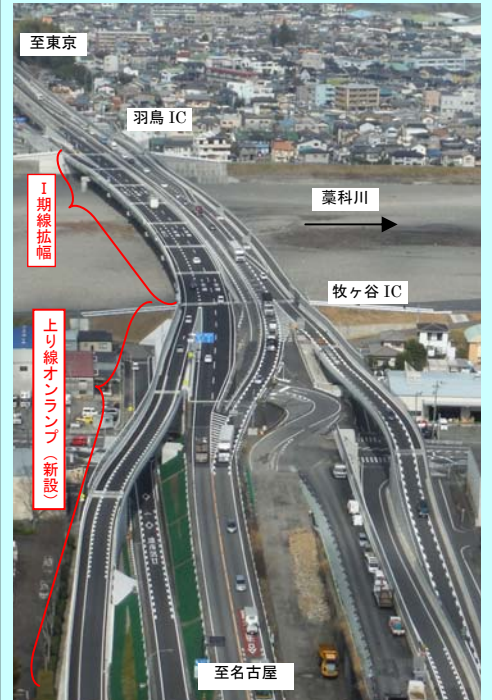
葦科川橋全景
