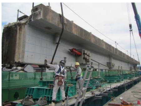
②旧橋撤去状況
