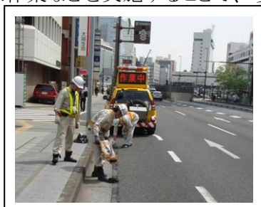
【道路パトロールで発見された道路損傷の復旧】
