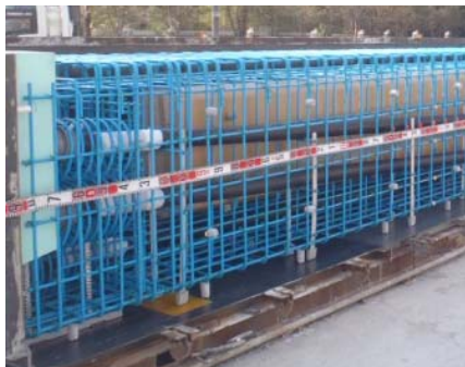
③セグメント製作(工場)エポキシ樹脂塗装鉄筋
