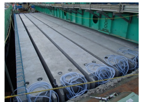
⑤主桁架設完了
