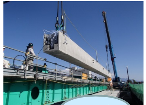
⑤主架設状況
