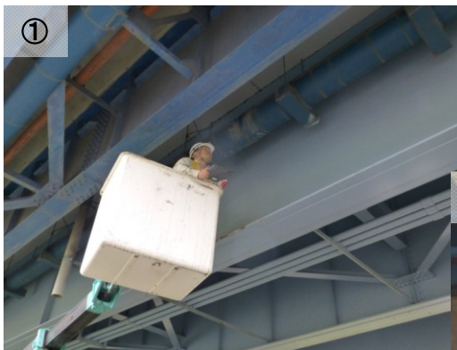
①高所作業車による近接目視 国道1号駿河大橋 桁の腐食・損傷箇所の有無を確認
