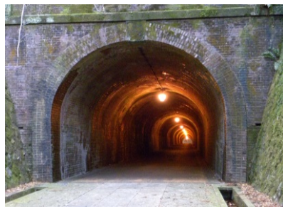
うつのや「宇津ノ谷峠」の明治時代に掘られたトンネル
