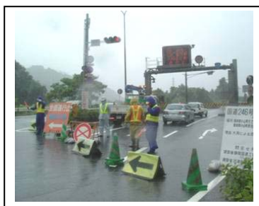
【雨量規制区間の通行規制により二次災害を防ぐ】
