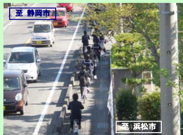
国道1号 水守地区歩道設置
