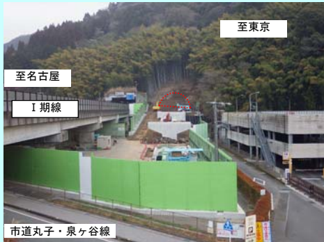
トンネル掘削の準備をしています。
