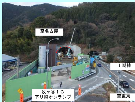
トンネルを掘削しています。
