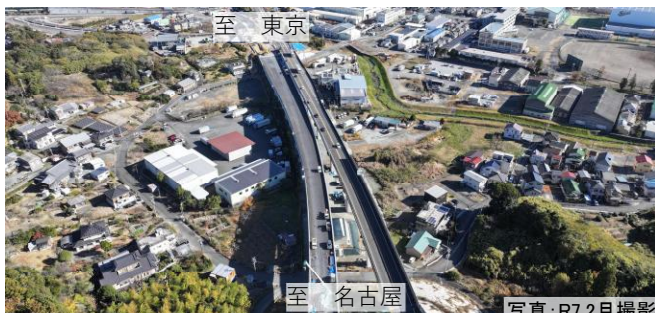
改築（国道1号藤枝バイパス4車線化事業） 写真：R7.2月撮影
