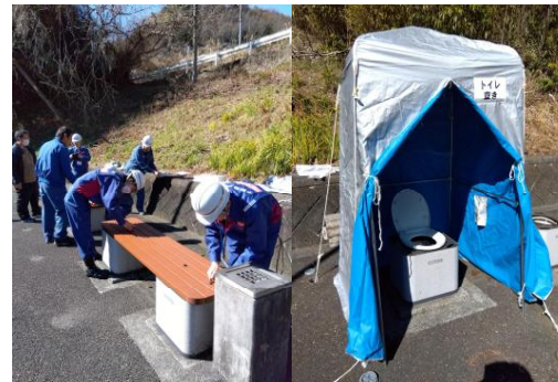
ベンチタイプトイレ設置訓練
