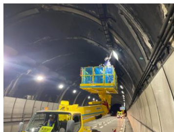
リフト車による打音検査
