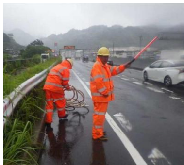
【緊急作業 落下物回収】
