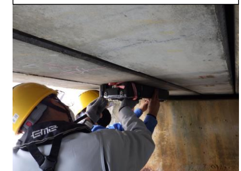
【PC鋼材非破壊検査】イメージ
