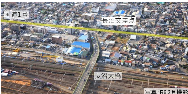
道路調査（静岡南北道路長沼立体） 写真：R6.3月撮影
