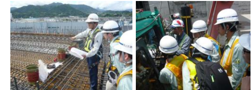
施工技術研修
