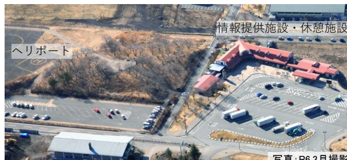
拠点（道の駅「朝霧高原」） 写真：R6.3月撮影
