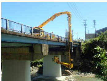
橋梁点検車による点検
