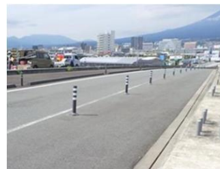
駐停車禁止車止め（ポストコーン）の設置 ※国交省により実施
