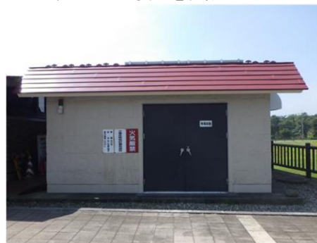
非常用自家発電施設イメージ
