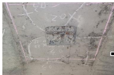
リフト車による打音検査
