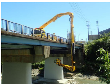
橋梁点検車による点検
