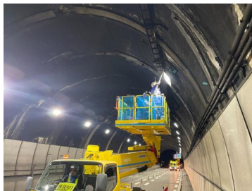
リフト車による打音検査
