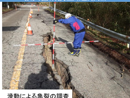
滑動による亀裂の調査
