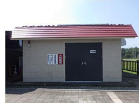
非常用自家発電施設イメージ
