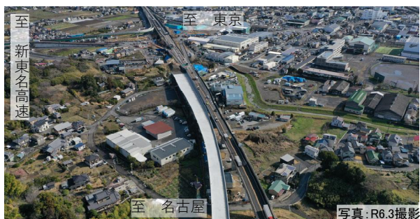
改築（国道1号藤枝バイパス4車線化事業）
