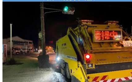
市道に堆積した土砂排除を支援(10/1)
