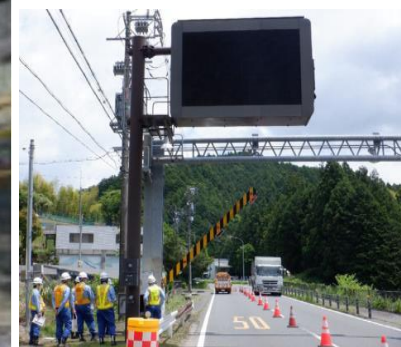
通行止め訓練
