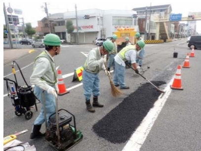
【小規模な路面補修】
