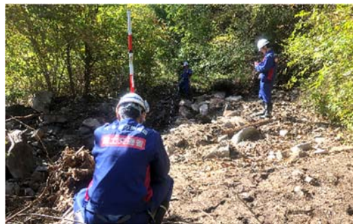
堆積土砂の計測作業
