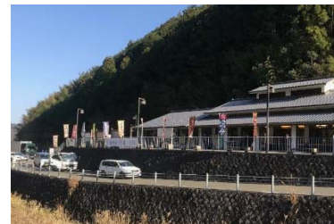
国道1号宇津ノ谷峠(静岡側)
