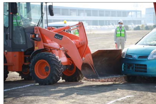
支障車両の道路外移動作業
