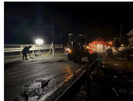
路面清掃作業
