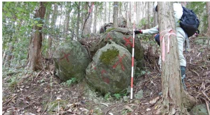
【現地での点検の状況】
