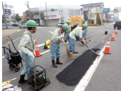
【小規模な路面補修】
