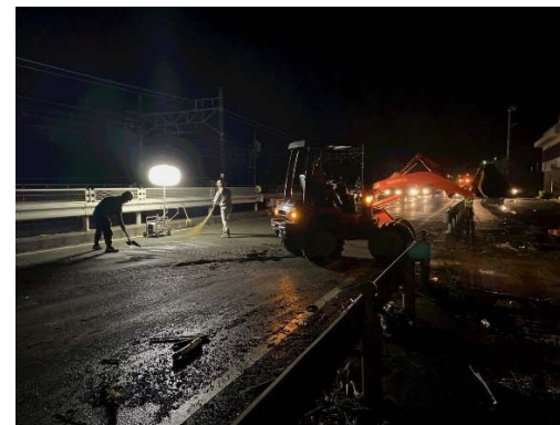
路面清掃作業
