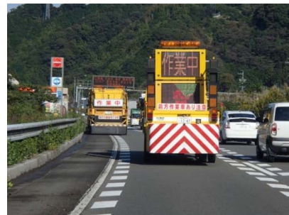
【機械による路面清掃】
