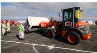
レンタル協会の重機を用いて静岡建設業協会が車両を撤去
