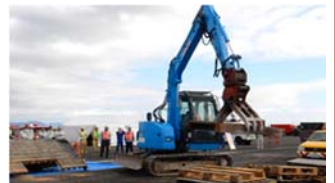
解体工事業協会がガレキを撤去
