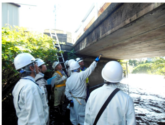
点検講習会（現地実習状況）
