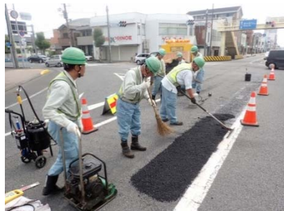
【小規模な路面補修】
