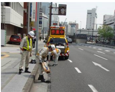
【道路パトロールで発見された道路損傷の復旧】
