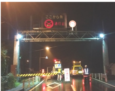
【事前通行規制区間(雨量)の通行規制により二次災害を防ぐ】
