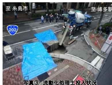
写真③ 流動化処理土投入状況
