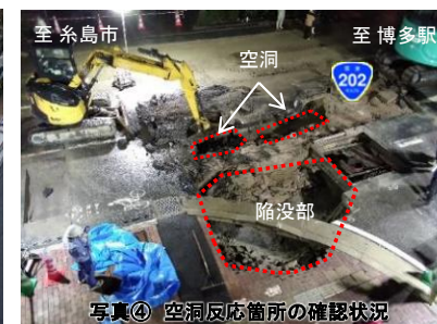
写真④ 空洞反応箇所の確認状況
