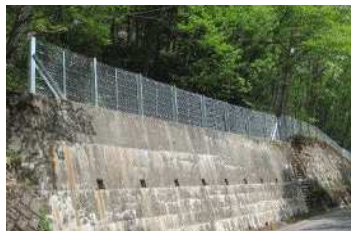
＜落石防止柵の取替＞
