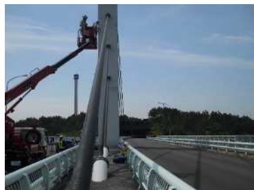
高所作業車による近接目視
