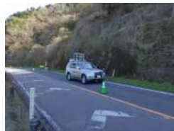
MMS※1を活用した 斜面・のり面点検
