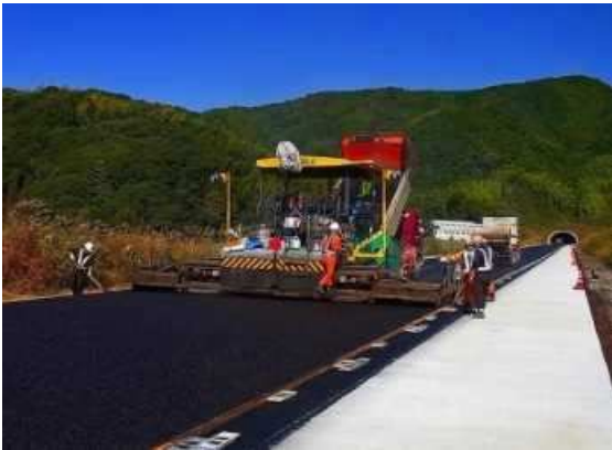
付図 1.1.3.1 コンポジット舗装の施工状況
