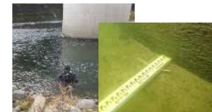
潜水調査による河床洗掘の把握
