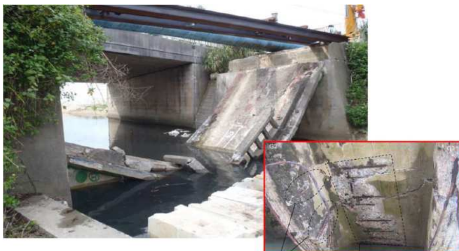
写真 2-1 老朽化が原因で落橋した国内事例
