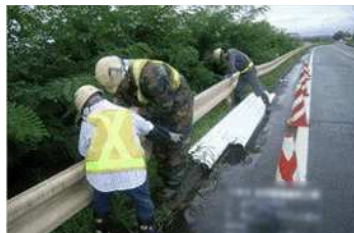
＜防護柵の取替＞
