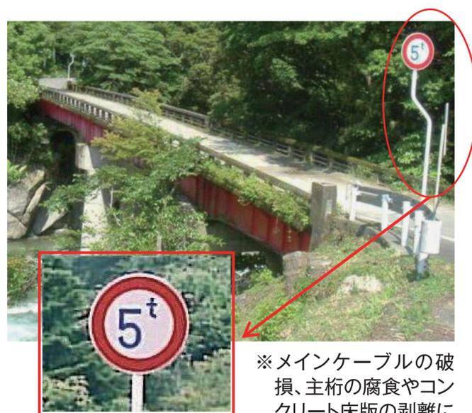
※メインケーブルの破損、主桁の腐食やコンクリート床版の剥離により通行規制を実施している事例
