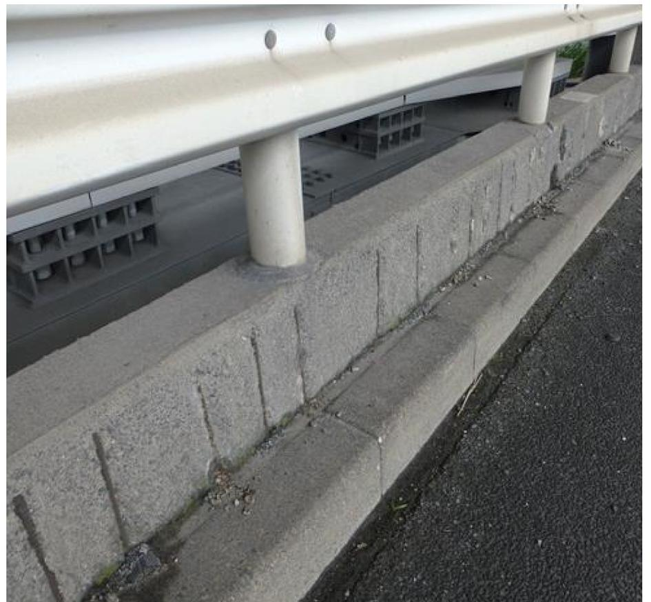
※中性化:本来コンクリートは強いアルカリ性ですが、大気中の二酸化炭素が浸透すると化学反応により中性に変化します。これにより鋼材などが錆びやすくなってしまいます。
