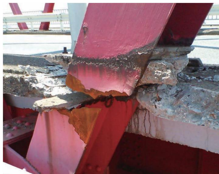
破断した鋼材、上下が完全に分離している
