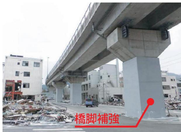
耐震補強済み(鋼板の巻立補強)
