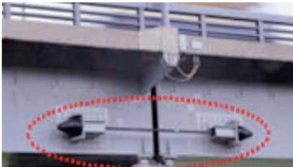
隣接する桁をケーブルで連結する構造
