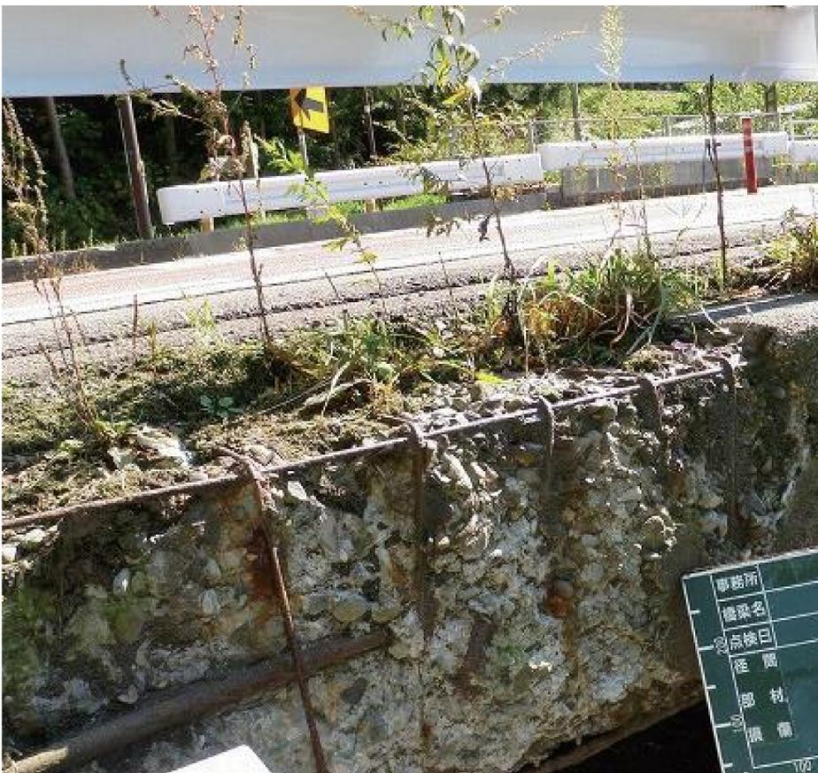
※凍害:コンクリート中の水分が0℃以下になった時の凍結膨張によって発生するものであり、長年にわたる凍結と融解の繰り返しによってコンクリート組織が徐々に劣化する現象。
