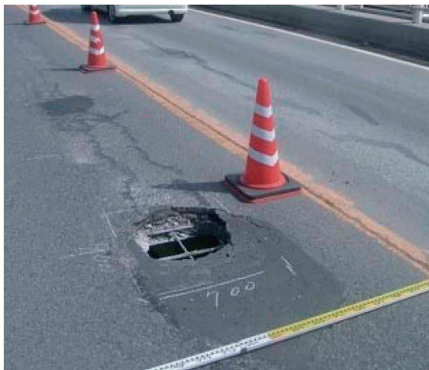
コンクリートの床版が抜け落ち、舗装に空いた穴
