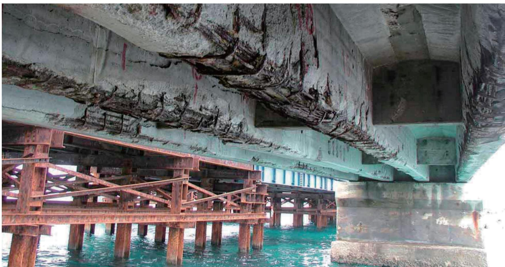
中の鋼材が腐食し、コンクリートが剥がれ落ちたところ
