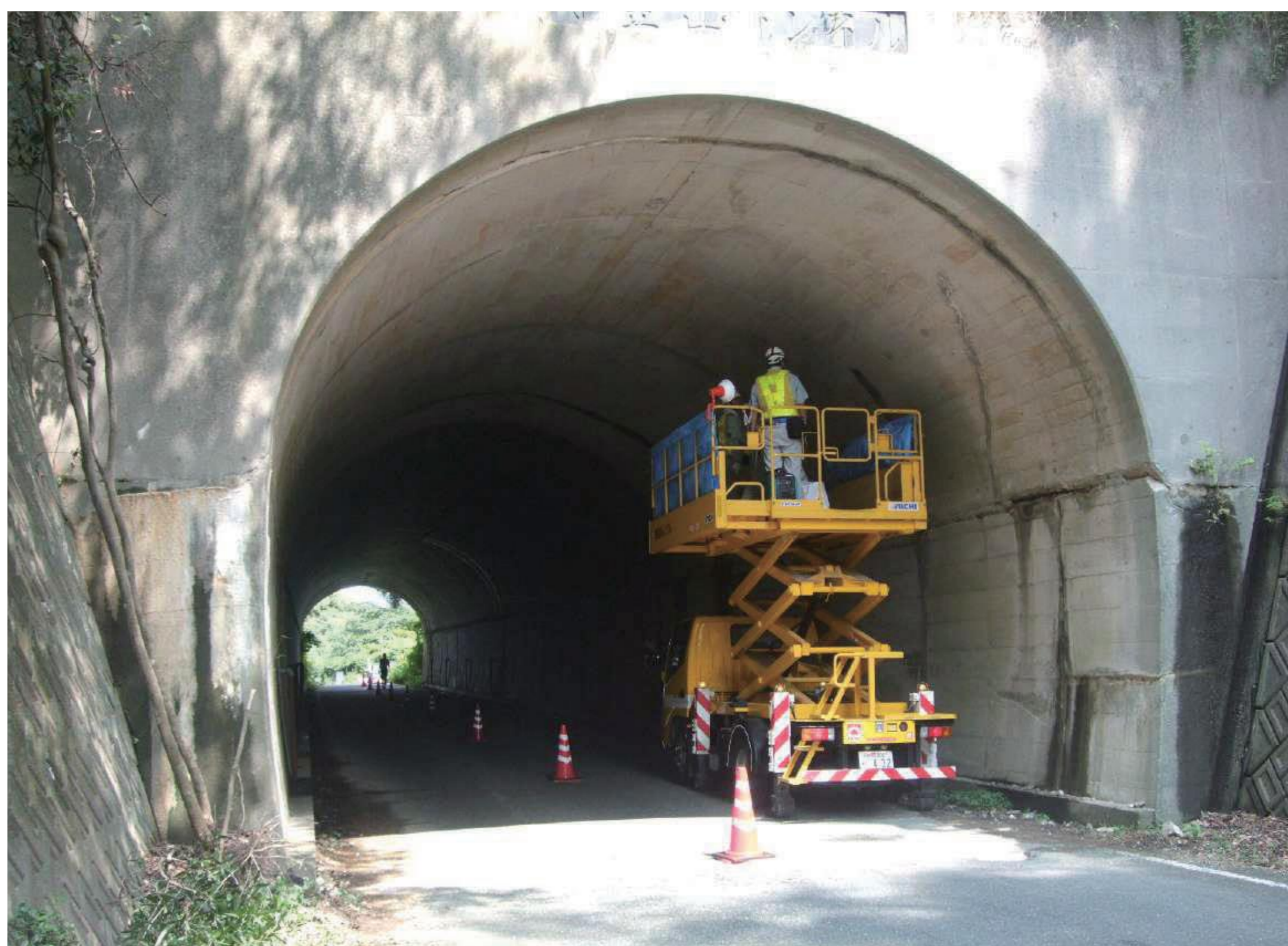
(トンネル点検の様子)
