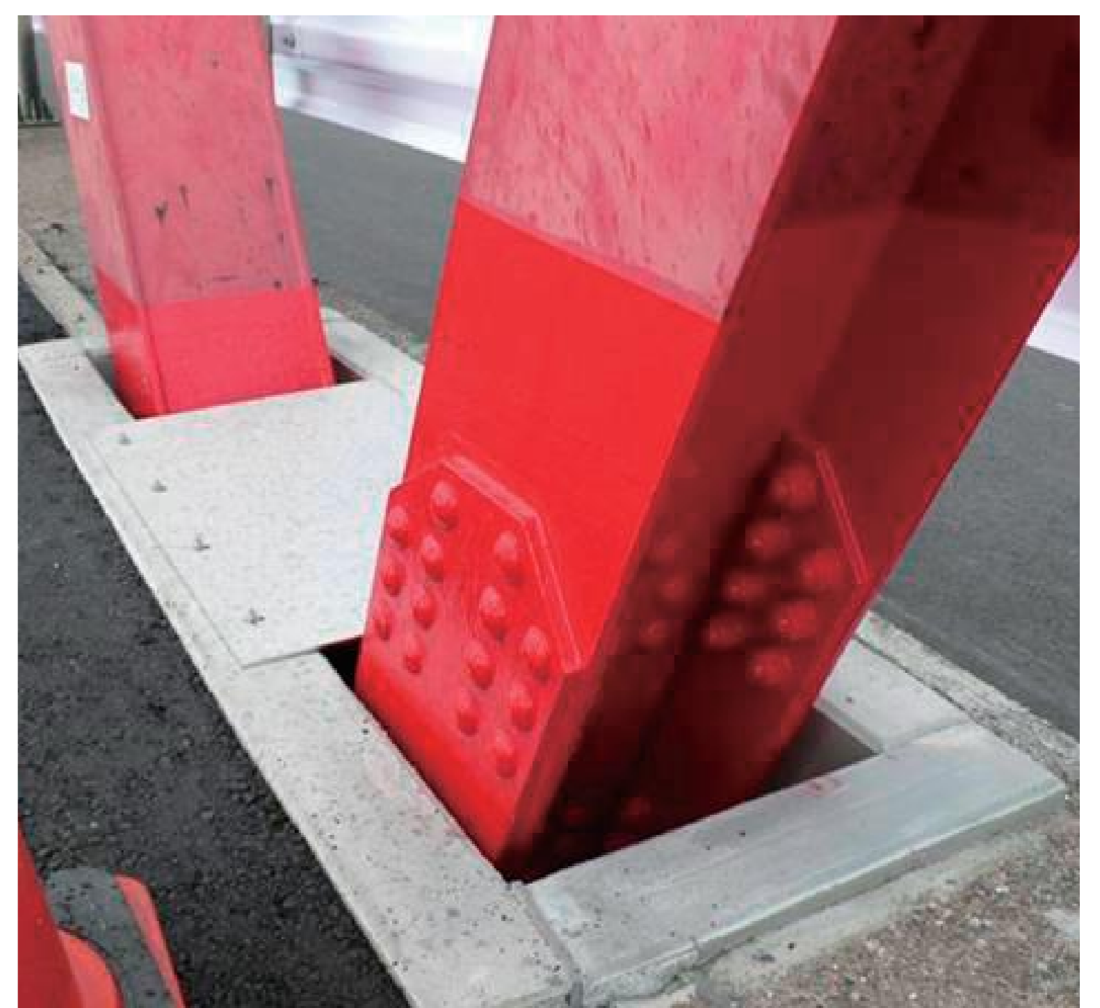
修繕後の状況(当て板補修・開口部設置)
