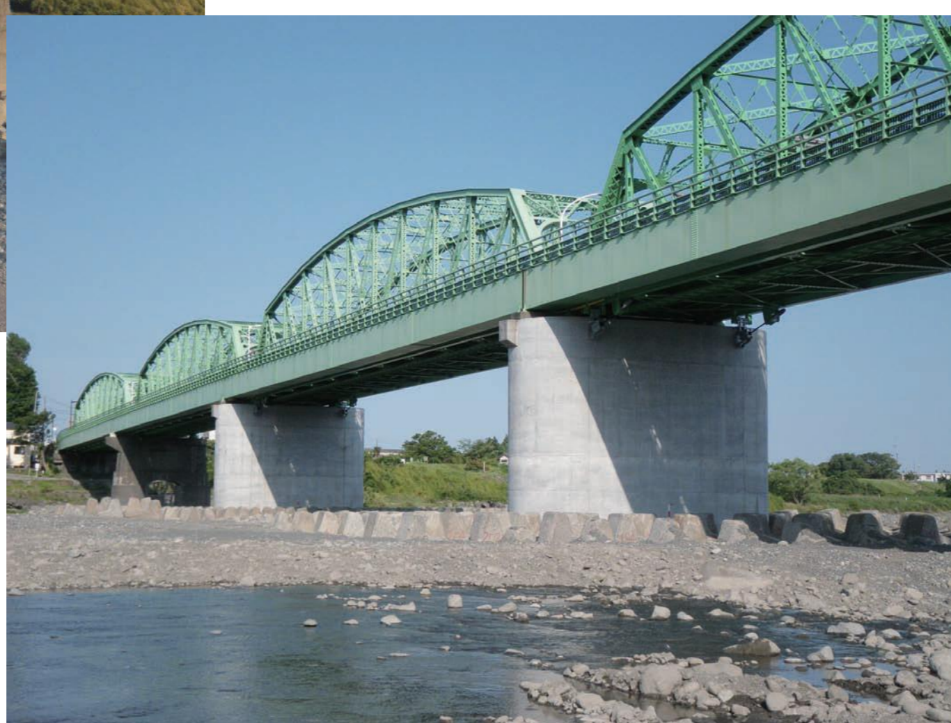
(塗装の塗り替え・耐震補強)
