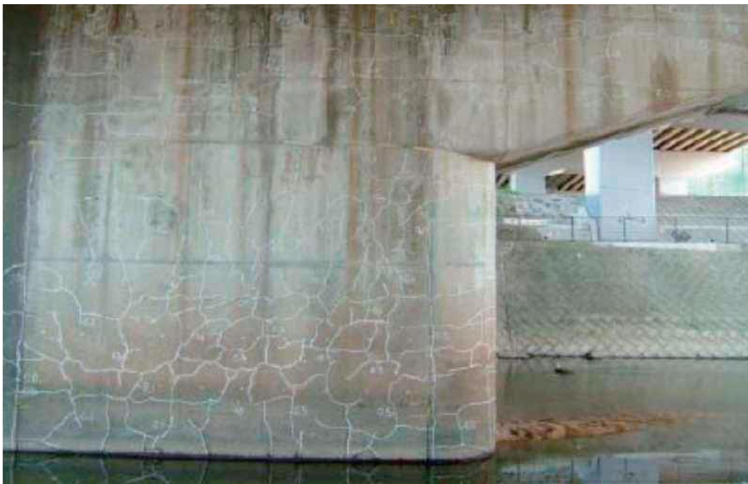
アルカリ骨材反応によりひび割れが発生
