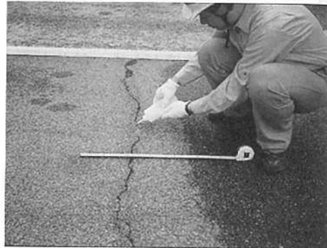
写真-4.2.12 樹脂系シール材の施工状況
