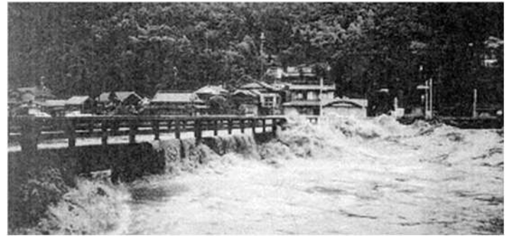
桁下高不足による支障事例
