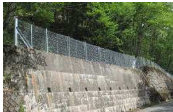
<落石防止柵の取替>
