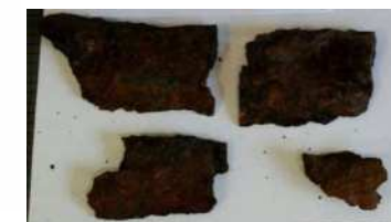
鋼部材(8cm × 4cm × 6mm) 軌道付近に落下
