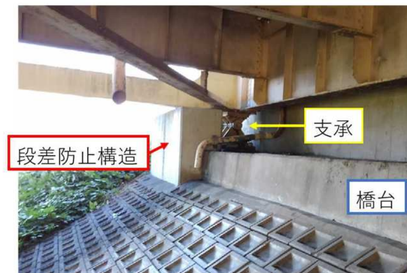
主桁下面の支承前面に設置した例
