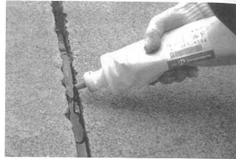
写真-4.2.11 シール材注入状況
