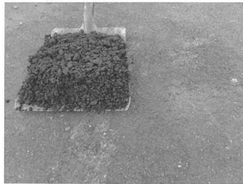
写真-4.2.8 常温全天候型施工前状況
