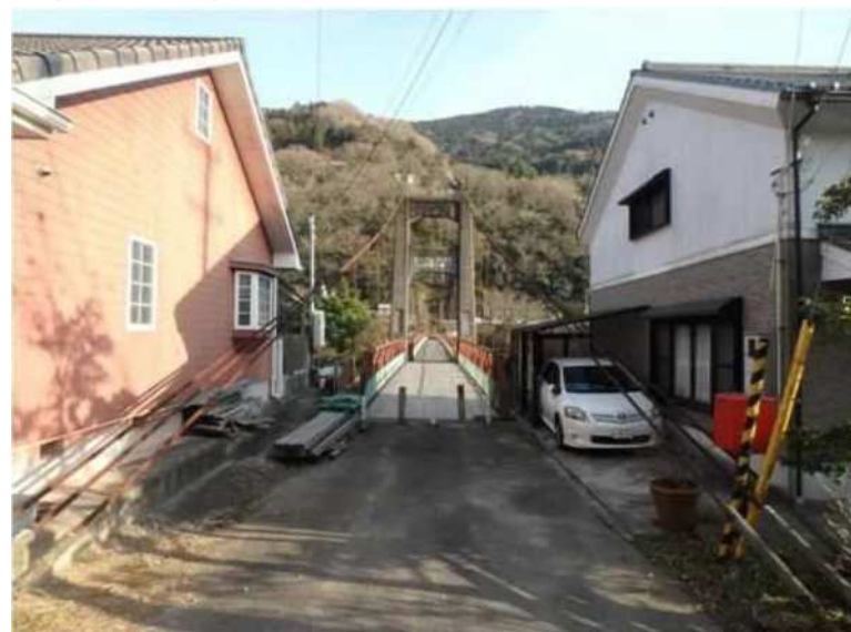
点検車や高所作業車が乗れない吊り橋
