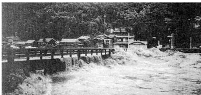
桁下高不足による支障事例
