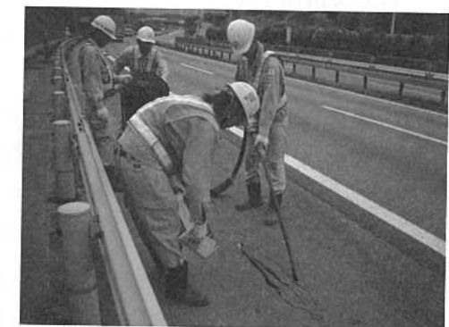
写真-4.2.10 シール材注入状況
