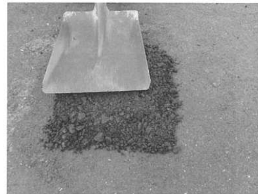
写真-4.2.9 スコップによる締固め状況
