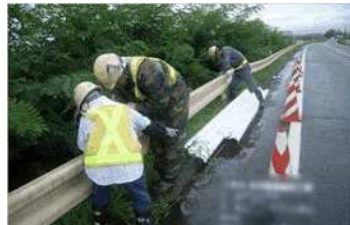
<防護柵の取替>
