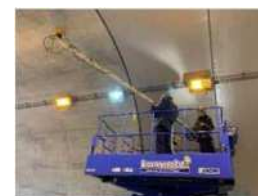
レーダーを利用したトンネル覆工の変状把握
