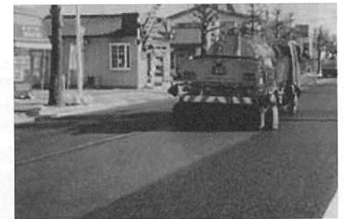
写真-4.2.14 フォグシール施工状況
