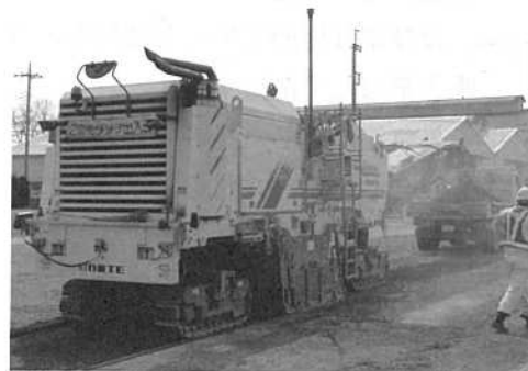
写真-4.2.13 路面切削機による切削状況
