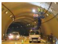
トンネル点検
