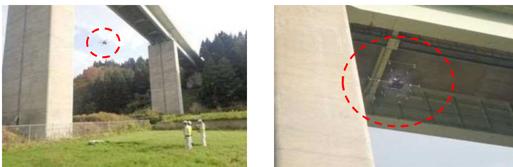
図Ⅱ－9 ドローンによる点検状況
