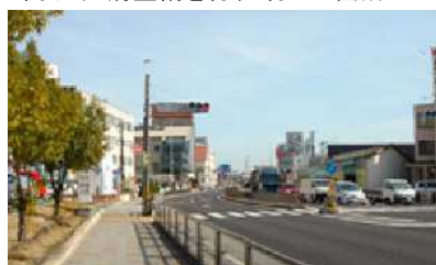
例:共同溝整備を行う・行った箇所
