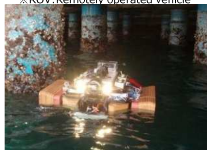
ROV※を用いて遠隔操作で 栈橋下面の目視調査を行う技術 ※ROV: Remotely operated vehicle
