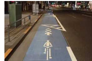
自転車の通行空間の確保 (国道246号：青山地区)
