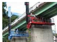
橋梁点検(点検車)
