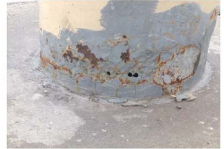
腐食片を取り除いた状態の例(下部)
