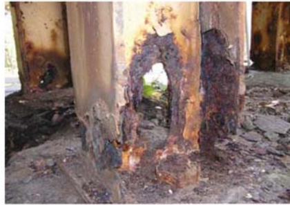
腐食片を取り除いた状態の例(下部)
