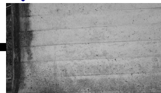
画像データ(トンネル)
