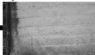
画像データ(トンネル)
