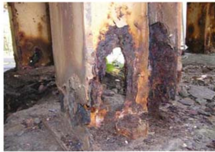
腐食片を取り除いた状態の例(下部)
