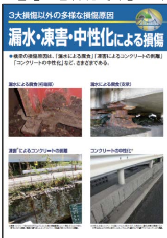
「道路の老朽化対策」パネル
