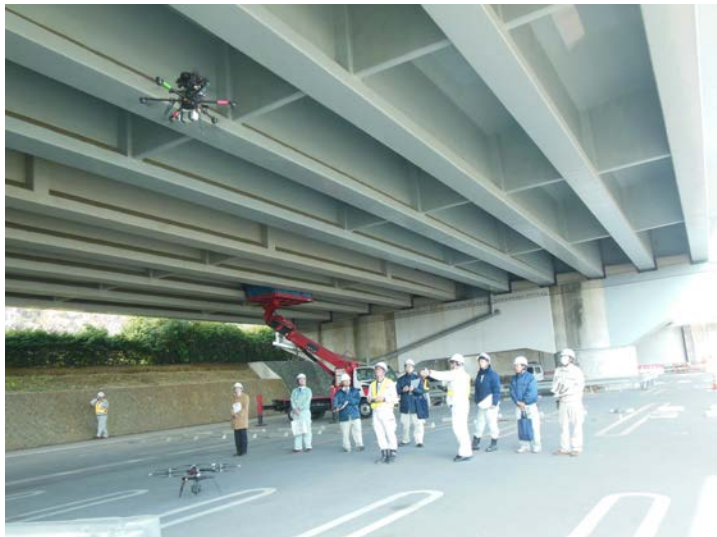
飛行系ロボットによる損傷箇所撮影技術
