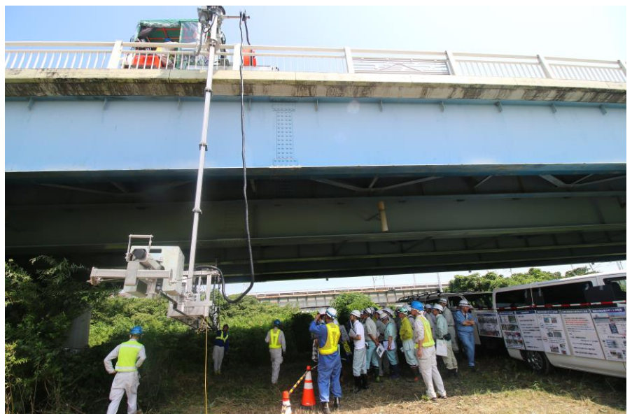
点検機械での実演講習 点検支援ロボット（歩道設置型）
