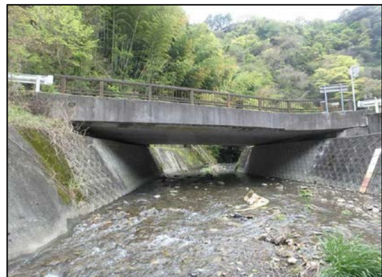
■点検・診断橋梁 大黒橋 1
